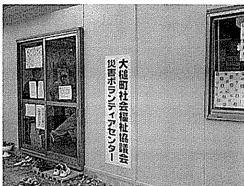
震災から1か月後に完成した大槌町協災害ボランティアセンターのプレハブの事務所。大槌町協の建物も全壊の被害を受けた
