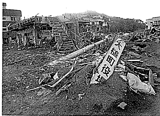
津波により壊滅的な被害を受けた大槌町役場
